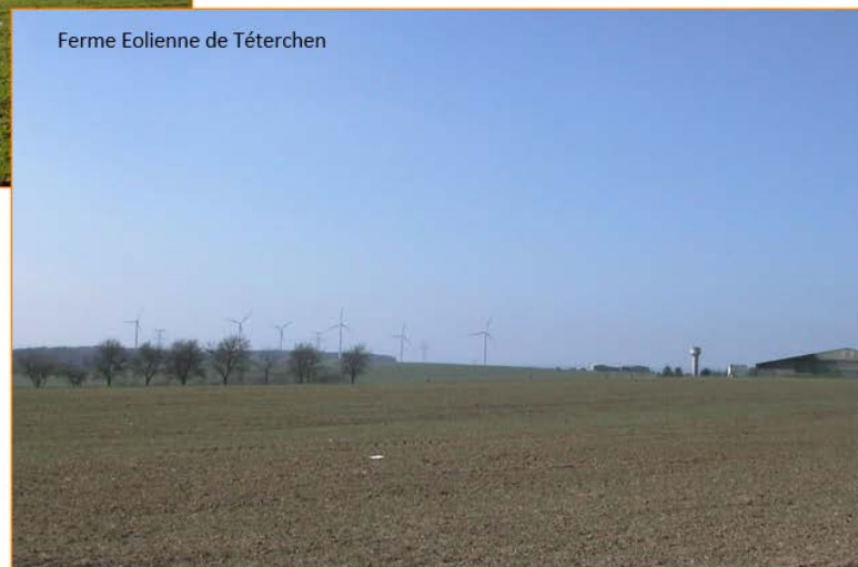
Figure 31 Comparaison Ferme éolienne de Téterchen (57)
